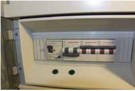
Kuva 3.5.a Tyypillinen veneen maasähkökeskus.
